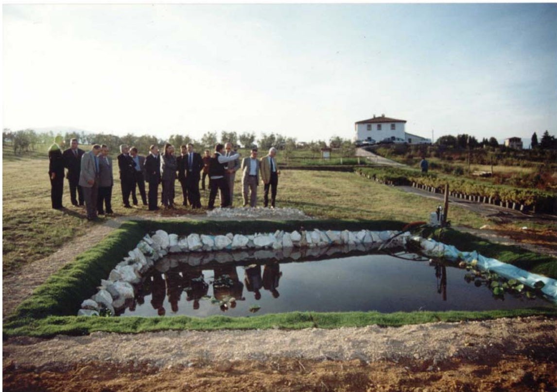
Foto 1 Impianto di Fitodepurazione del tipo FWS a servizio di attività agrituristica prima dello sviluppo delle piante (immagine gentilmente concessa da Ing.ambientale Ilaria Baldi)
