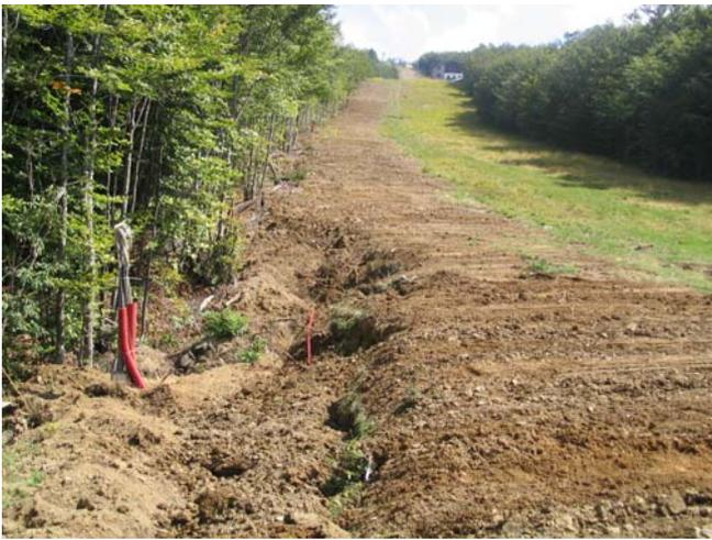
In primo piano uno dei pozzetti-idranti installati lungo le piste e sullo sfondo la fascia di intervento
