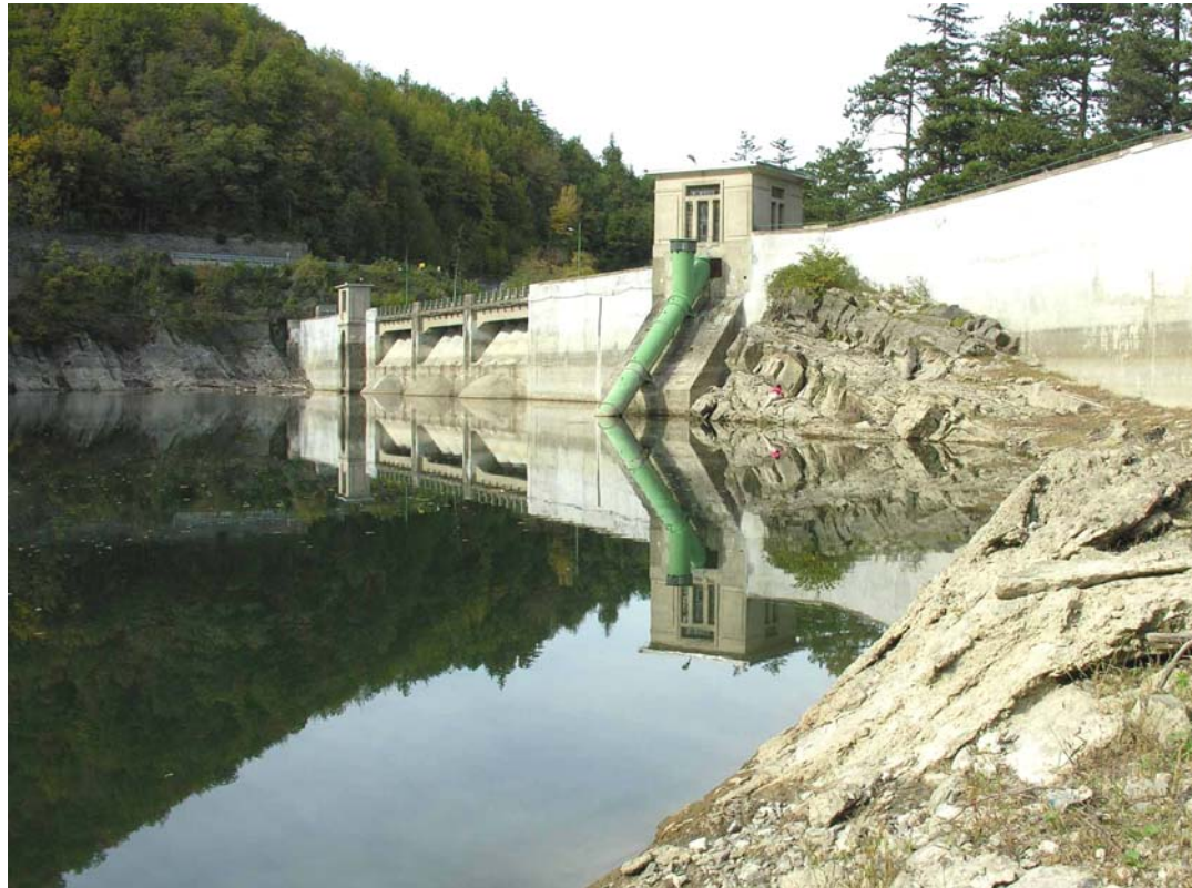
Fig. 41. Veduta della Diga di Pavana (foto S. Cianfanelli).
