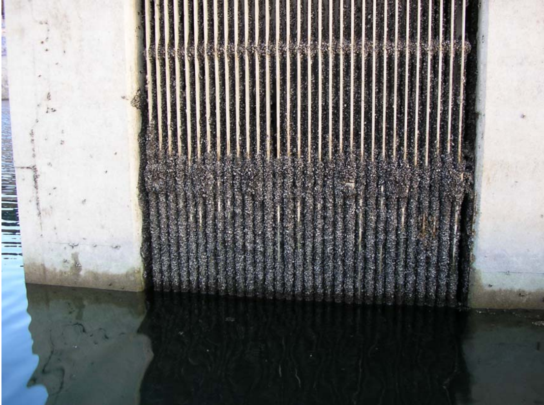
Fig. 32. Presa d'acqua del lago di Bilancino la cui griglia è completamente intasata da grappoli di molluschi.
