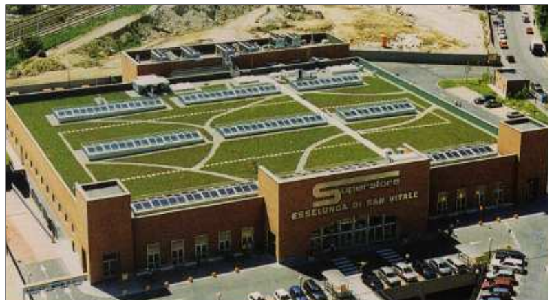
Esempio di verde pensile estensivo (tetto verde)
