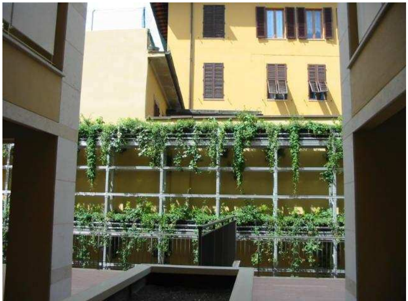
Verde parietale continuo su supporto di ancoraggio (costruzione di un giardino in verticale)
